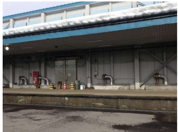
本社工場 冷凍倉庫外観
