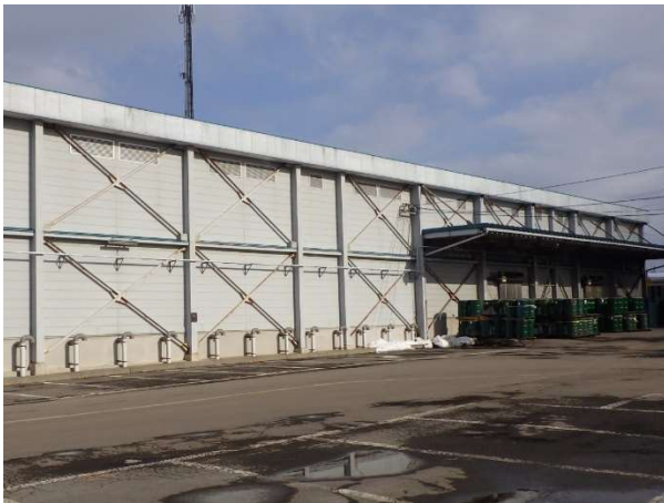
本社工場 冷凍倉庫外観
